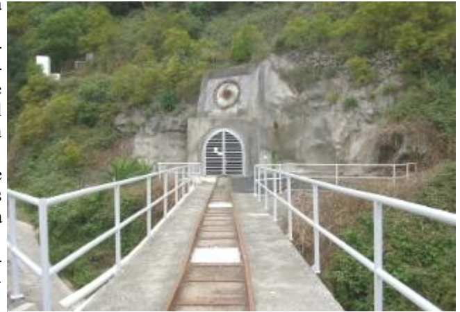
Boca Oeste del Túnel del Trasvase que da hacia Breña Baja.
