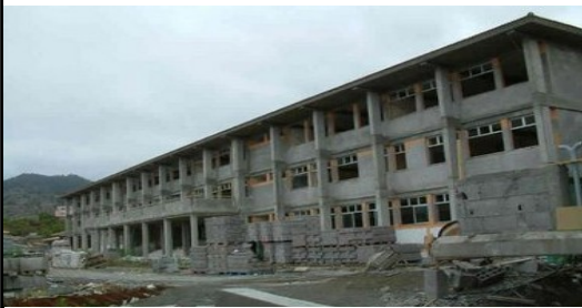
Imagen del Centro en pleno proceso de construcción
